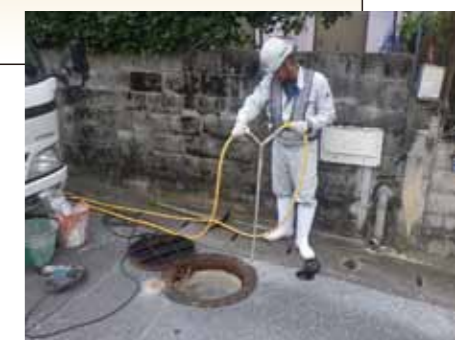
2. ノズルを差し込み注入
