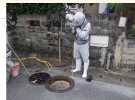
1. 注入孔の削孔
